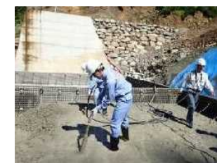
コンクリート打設体験
